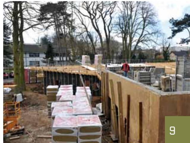
**Le procédé utilisé pour construire le bâtiment de l'hôpital de jour de pédopsychiatrie** permet de réduire le transport de matériaux en utilisant de la terre prélevée sur place. Il offre aussi des performances intéressantes au niveau isolation.
